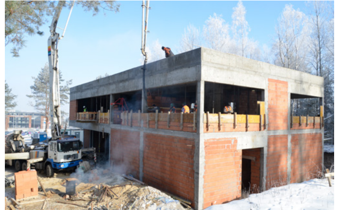
Luty 2017 roku – budynek w stanie surowym otwartym.
