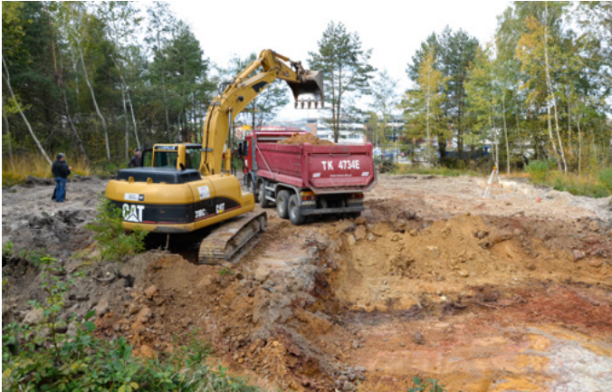
Wrzesień 2016 rok – rozpoczęcie budowy.
