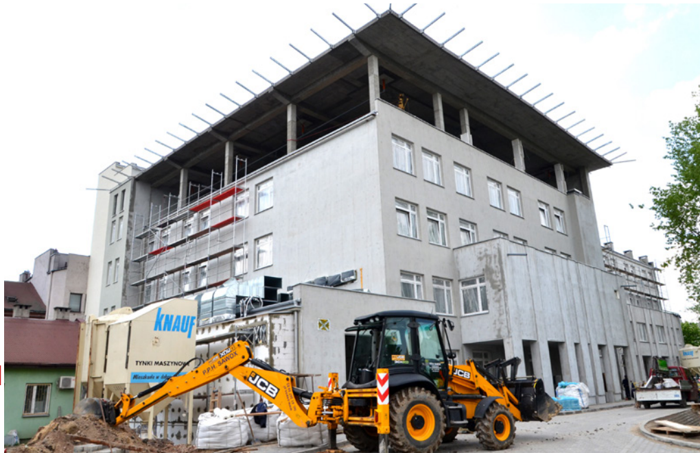
Trwa rozbudowa Szpitala Kieleckiego. Na dachu tego pawilonu będzie lądowisko helikopterów.
