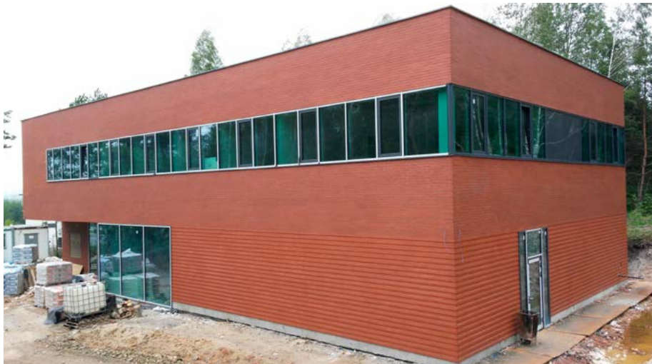
Tak teraz wygląda budynek nowej siedziby Izby od strony południowo-zachodniej.
