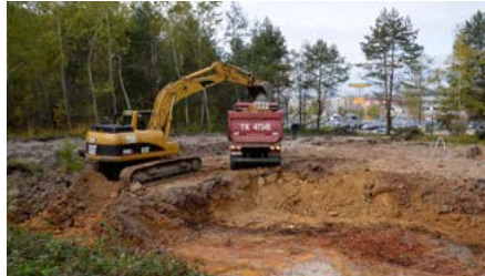
Połowa października 2016 - rusza budowa.
