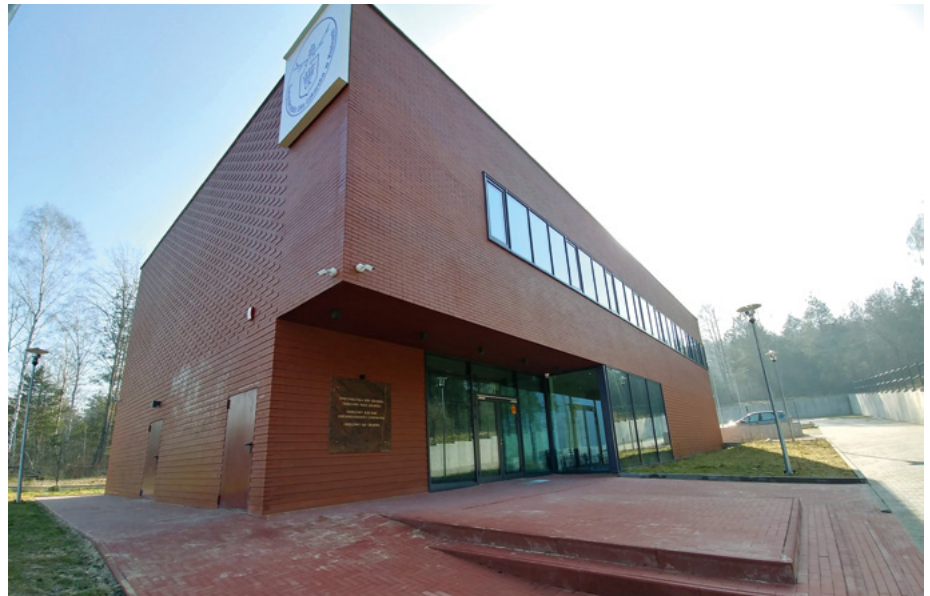
Izba Lekarska ma nową siedzibę - przy al. ks. J. Popiełuszki w Kielcach.
