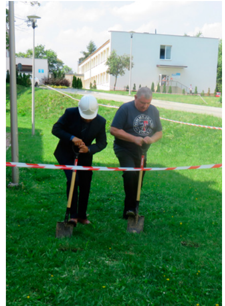
Wbito pierwszą łopatę pod budowę centrum urazowego w Kielcach.
